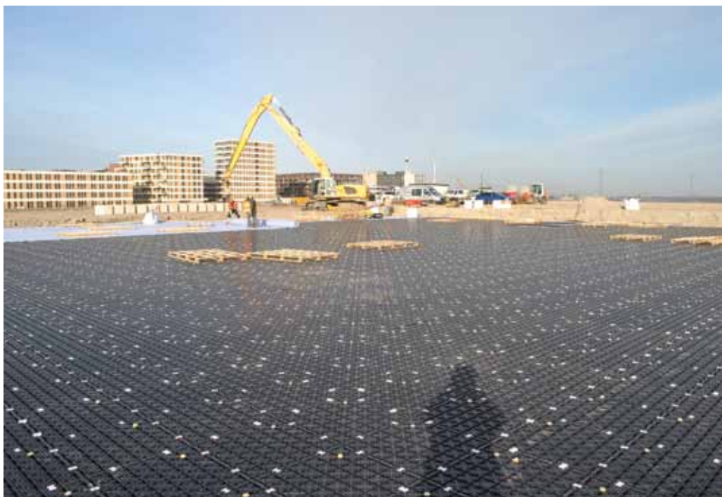
Met het Permavoid Capillair Irrigatie Systeem (PCIS) van TGS wordt een kunstmatige waterspiegel gecreëerd. De units hebben een hoogte van 8,5 cm en liggen op 1 m diepte onder de laag bomenzand.
