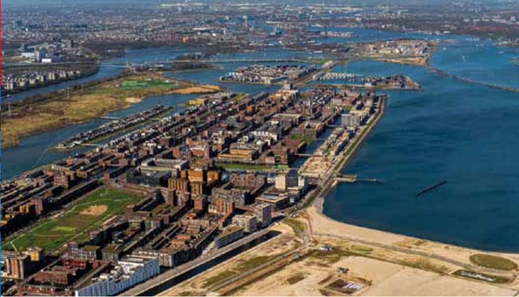
Luchtfoto van het Bomencarré op het Centruimeiland tijdens de aanleg.
